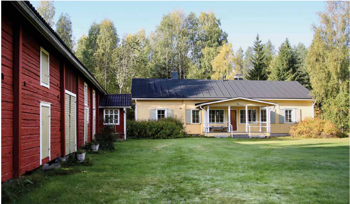
Tauno Tönning kunnostutti hankkimiensa kiinteistöjen usein hyvin huonossa kunnossa olleet rakennukset asuttavaan kuntoon. (LL).
